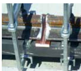
Alignement et préchauffage
