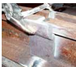
Soudage de l'âme de rail
