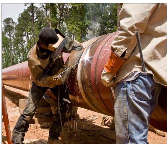
Soldadura de tubería a campo traviesa
