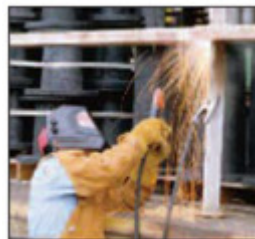
Soldadura de Electrodo Revestido con CD
