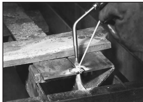
Figure 18. Brasure au chalumeau à gaz
