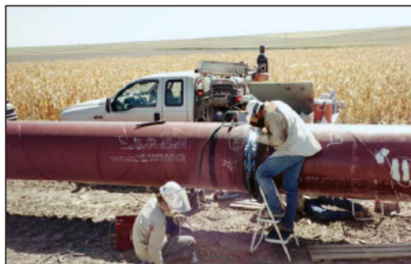
Soldadura de tubería en campo.
