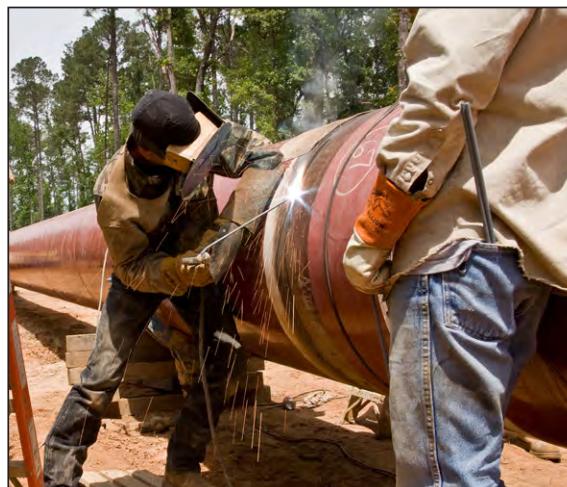
Soldagem de tubo em campo.
