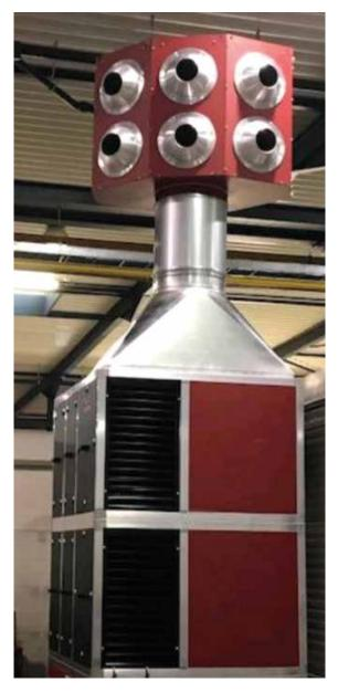
AMBICLEAN è dotato di cartucce filtranti con membrana PTFE ad altissima efficienza (99,97% per particelle di 0,15 µm). Tuttavia, i gas emessi nei fumi di saldatura non possono essere trattati in sicurezza da nessun dispositivo. Pertanto, si consiglia di associare un volume d'aria nuovo corrispondente al 20% del volume dell'aria trattato dall'impianto.
