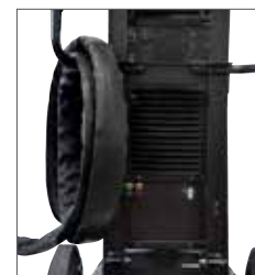
Sistema de control de cables
