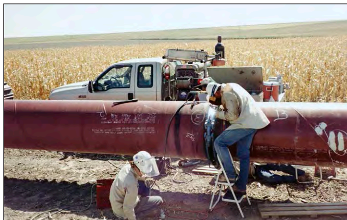
Soldadura de tuberías a campo traviesa.
