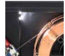
Iluminación LED en el interior del devanador
