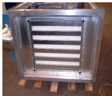
**NB :** Pour le remplacement des cassettes filtrantes, utiliser toujours des lunettes de protection et un masque respiratoire pour prévenir tout risque de contact et d'inhalation avec les particules collectées. L'alimentation électrique doit toujours être coupée par le sectionneur ou par les fusibles. Si le filtre est équipé d'une prise d'alimentation, celle-ci devra être détachée de son embrase murale.
